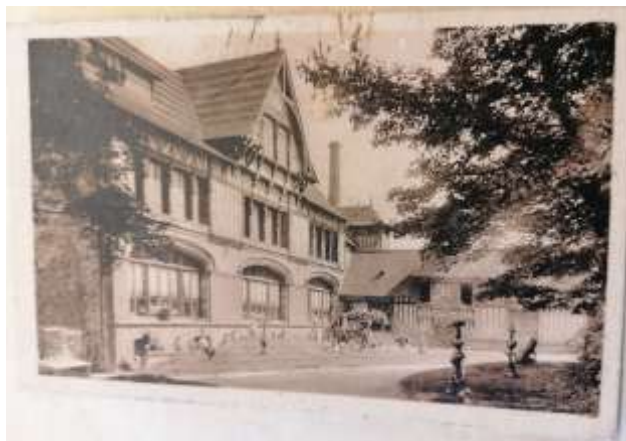
AD14 - Hall d'exposition de biais avec cheminée d'un des deux fours en arrière-plan
