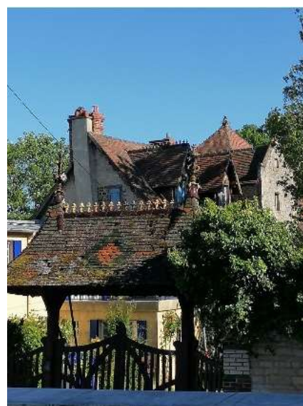
Entrée du 22 rue de Calix
