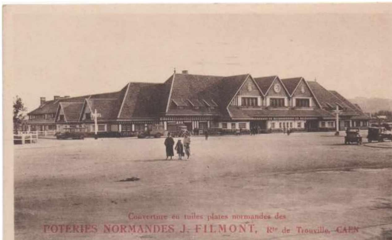
Collection particulière – couverture de la toiture de la gare de Trouville Deauville
