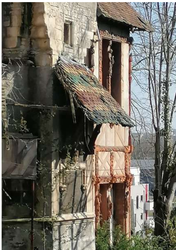
Vue de la façade : tuiles vernissées, faux pans de bois
